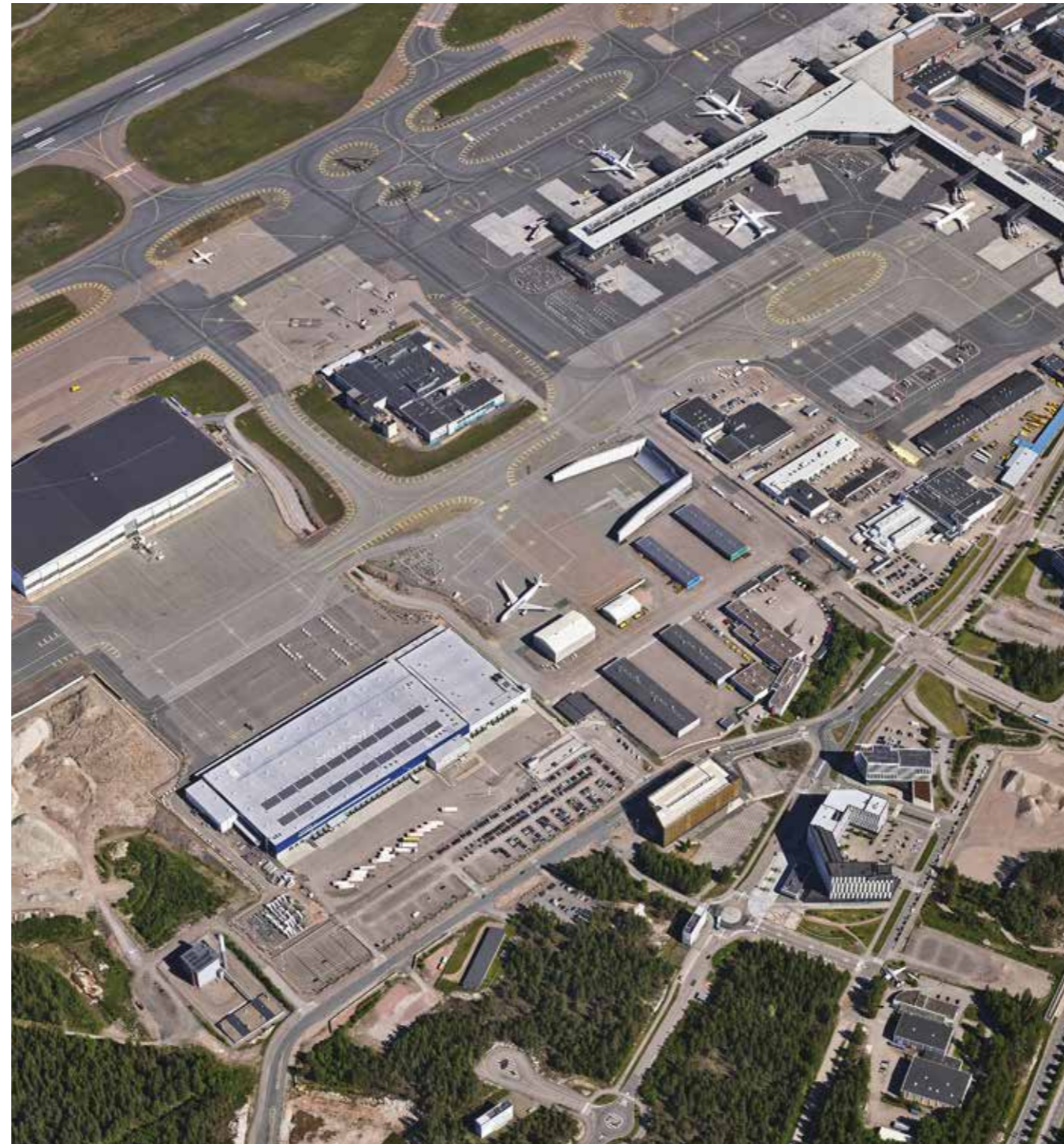
Kuva 25. Lentokoneiden huoltojen yhteydessä tehtävät koekäytöt suoritetaan korkeilla meluseinäkeillä varustetulla koekäyttöpaikalla. Koekäyttöpaikka on kolmiseinäinen rakenne kuvan keskiosassa. © Vantaan kaupungin karttapalvelu
